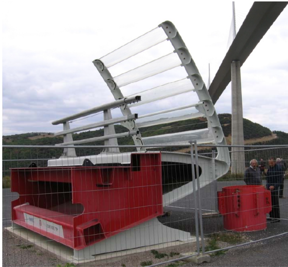
Figure 18 : Ecrans brise-vent sur le Viaduc de Millau
